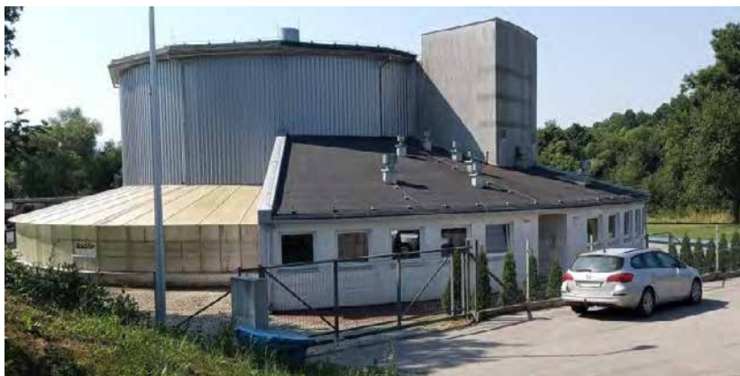
Oczyszczalnia ścieków, Słopnice, Polska – 600 m 3 /d
