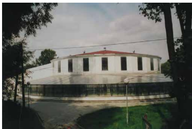
Oczyszczalnia ścieków Paczków, Polska – 2'500 m 3 /d
