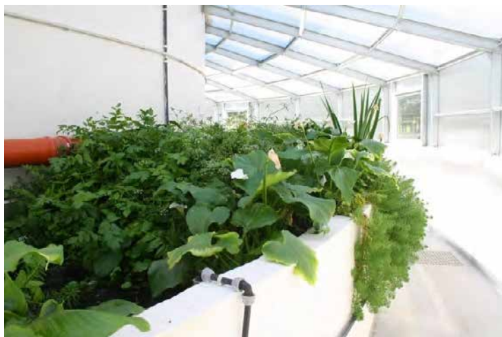
Hydroponik – III stopień oczyszczania w oczyszczalni ścieków, Sulmierzyce, Polska
