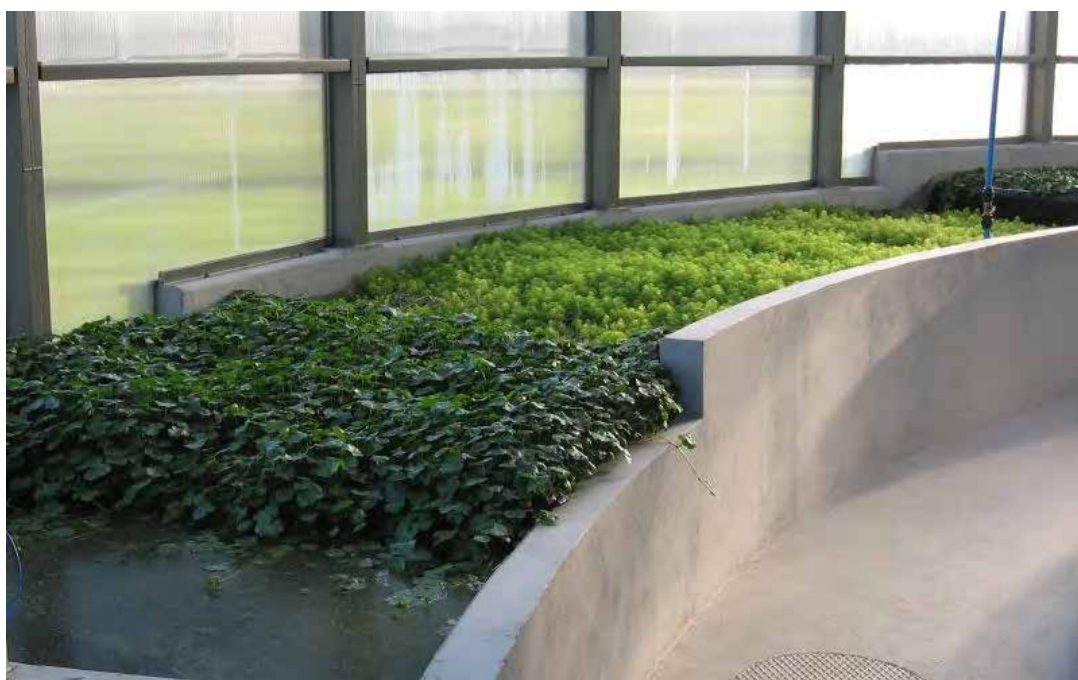
Hydroponik – III stopień oczyszczania w oczyszczalni ścieków, Łękawica, Polska
