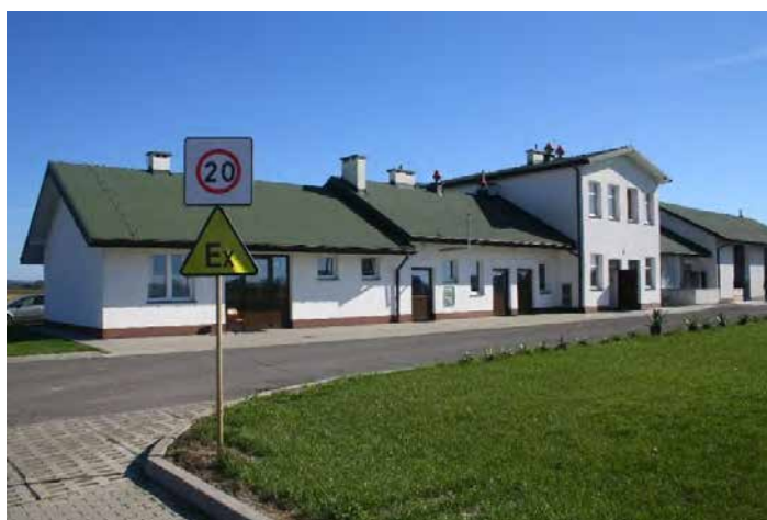
Oczyszczalnia ścieków, Turze Pole, Polska – 500 m 3 /d
