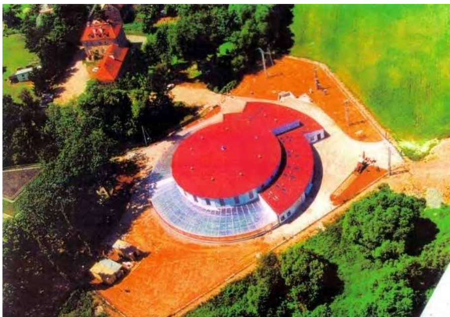
Fot.3 Oczyszczalnia ścieków, Paczków, Polska, Przepustowość 2'500m 3 /d (20'000 mieszkańców), pow. działki 0,5ha, pow. zabudowy 2'100m 2
