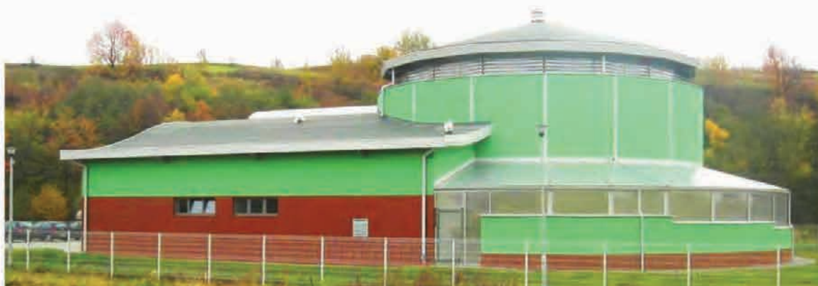
Fot.1 Oczyszczalnia ścieków wybudowana w tej technologii
