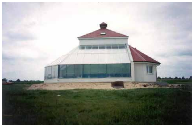
Oczyszczalnia ścieków Tuchorza Stara, Polska – 250 m 3 /d
