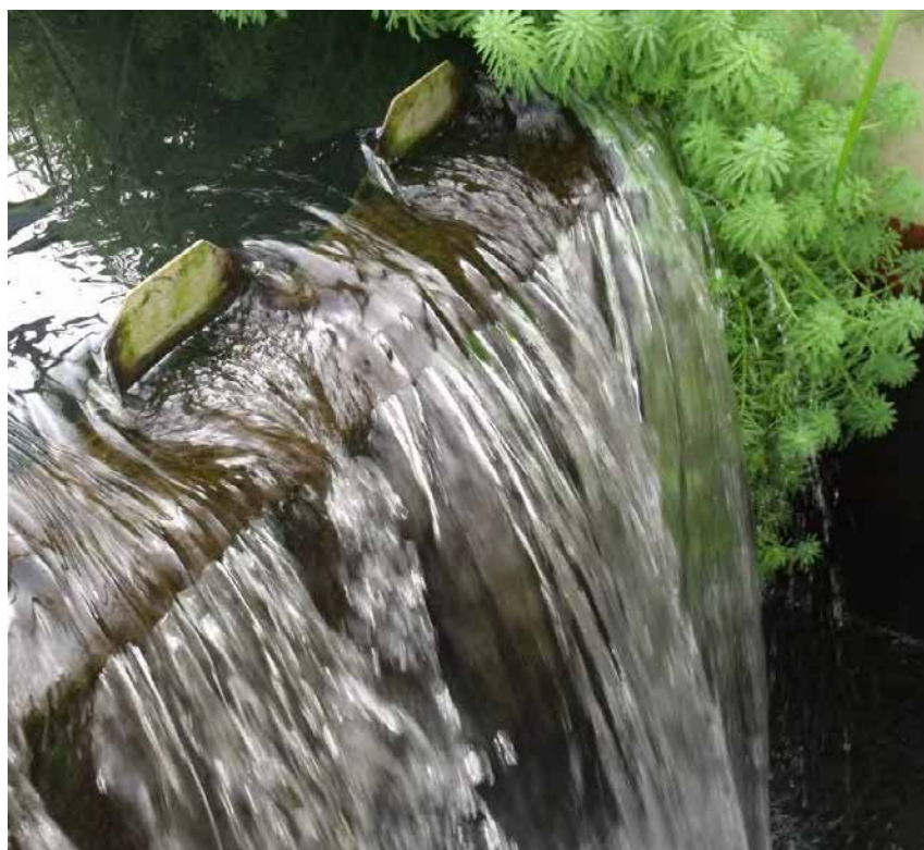
Fot 5 Odpływ ścieków oczyszczonych z oczyszczalni ścieków w samosterownej technologii hybrydowej
