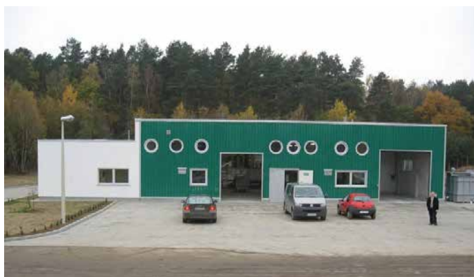
Oczyszczalnia ścieków, Łagów, Polska – 900 m 3 /d
