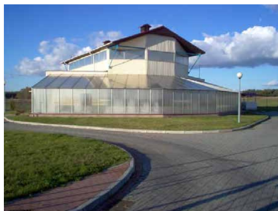
Oczyszczalnia ścieków Drzonów, Polska – 200 m 3 /d
