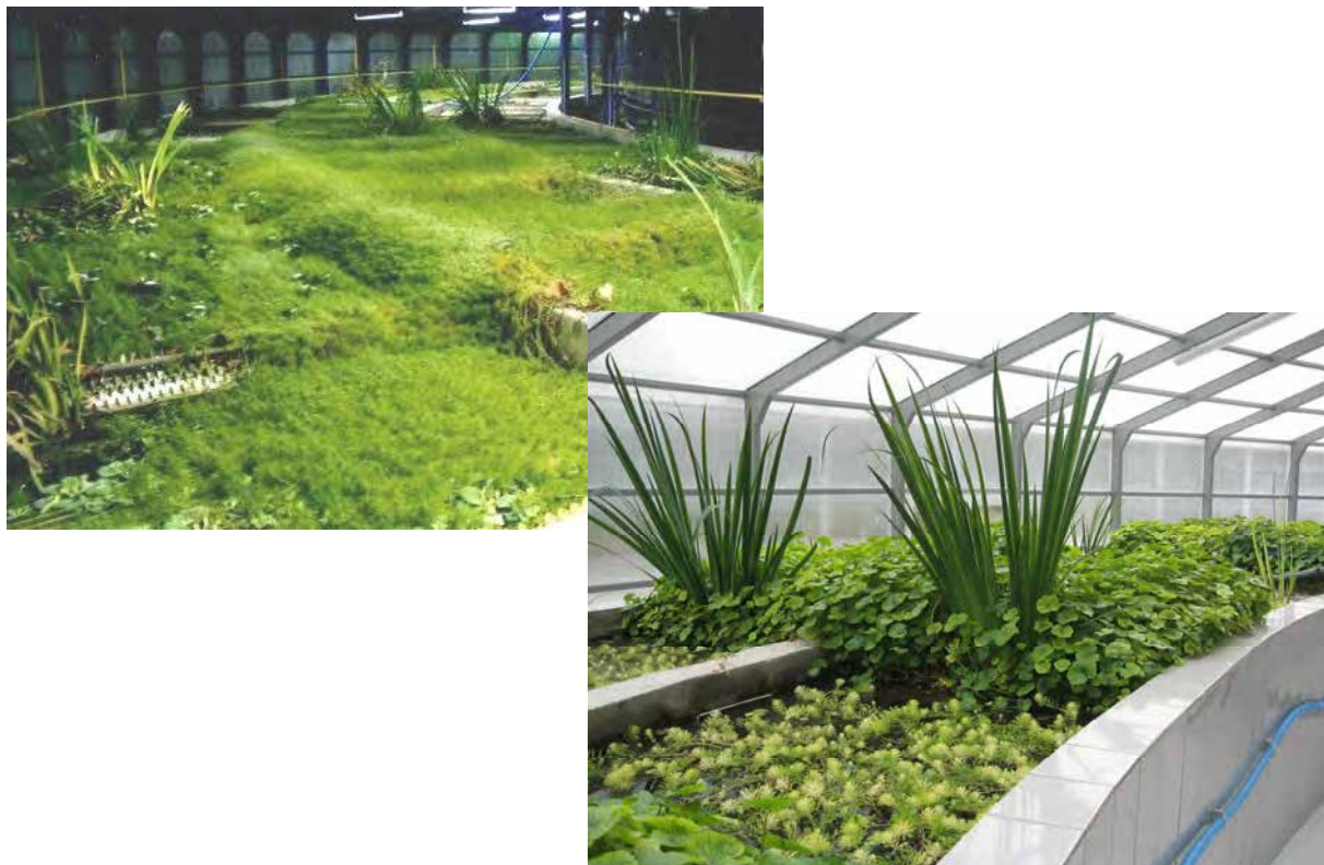
Fot.4 Sztuczna rzeka (hydroponik) oczyszczalni ścieków w miastach Paczków i Słopnice
