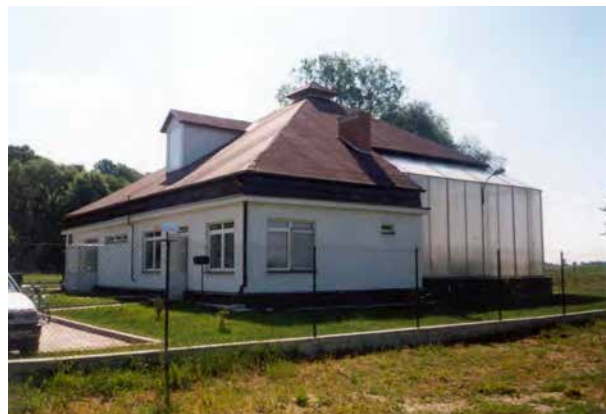
Oczyszczalnia ścieków Bargłów Kościelny, Polska – 200 m 3 /d
