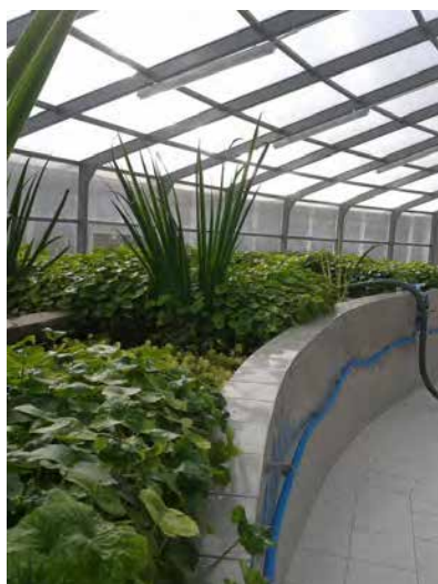
Hydroponik – III stopień oczyszczania w oczyszczalni ścieków, Słupnice, Polska
