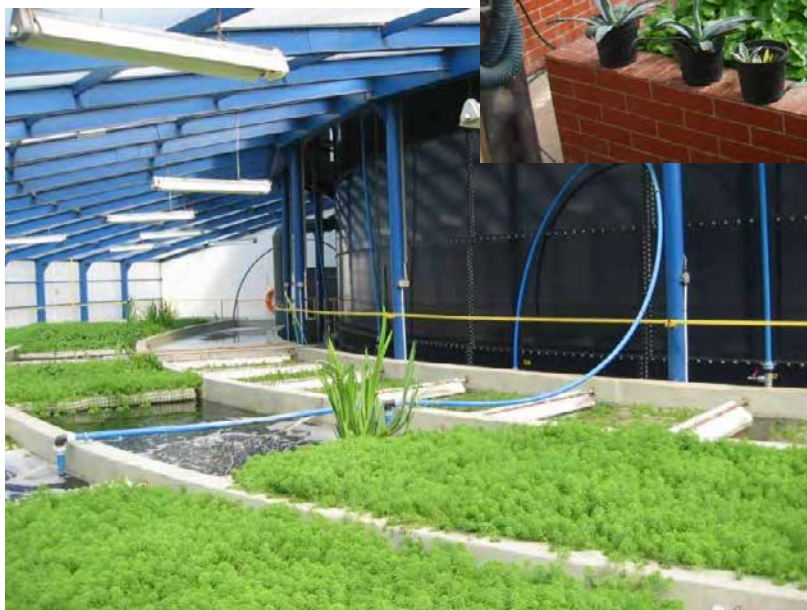
Fot. 6. Sztuczna rzeka (hydroponik) w oczyszczalniach ścieków w naszej technologii
