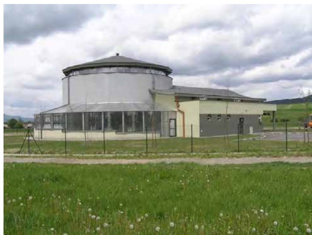
Oczyszczalnia ścieków Łękawica, Polska – 600 m 3 /d
