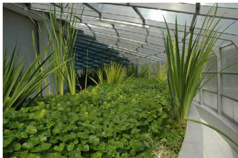
Hydroponik – III stopień oczyszczania w oczyszczalni ścieków, Słupnice, Polska
