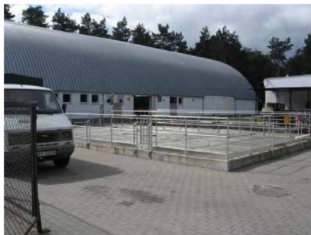
Oczyszczalnia ścieków Sulejówek, Polska – 3'200 m 3 /d
