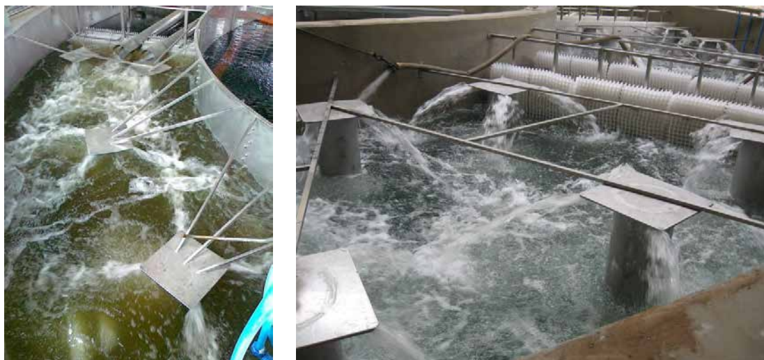
Fot. 7. Widok pracujących aeratorów w oczyszczalni ścieków w miejscowości Turze Pole i Łągów
